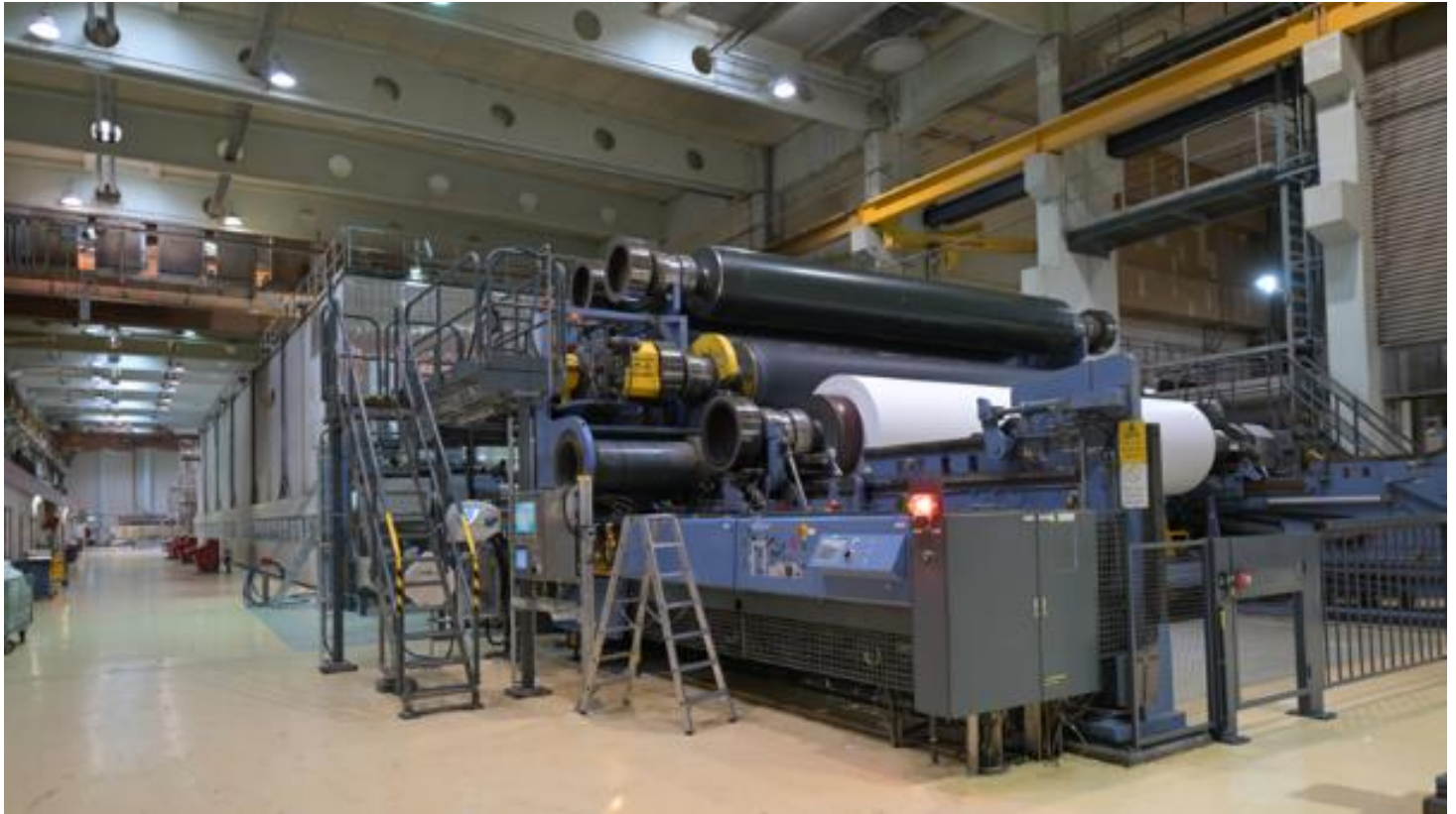
Die PM6 nach dem erfolgreichen Umbau
